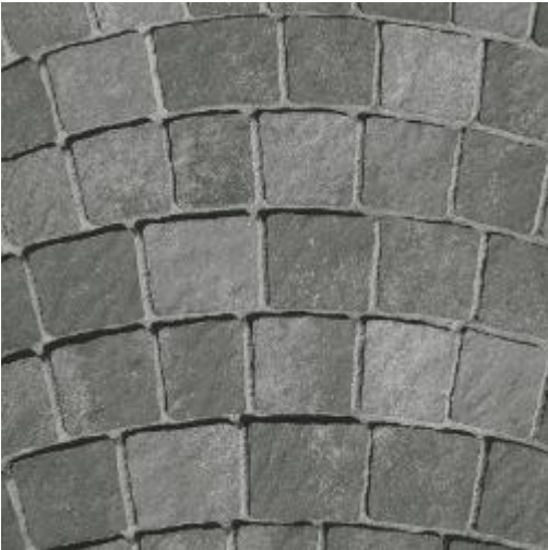
Materiál povrchu vozovky – betónová dlažba
