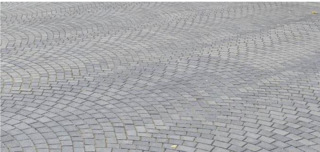
Materiál povrchu vozovky – betónová dlažba
